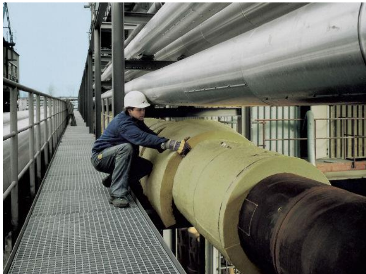
Рис. 1. Застосування мінеральної вати для утеплення теплових мереж
