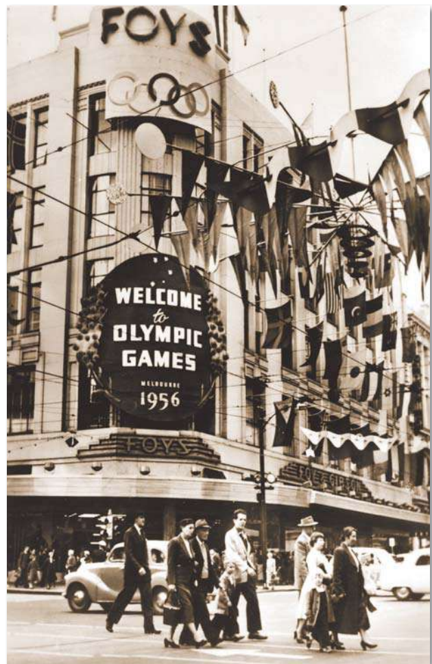
Центральний універмаг Мельбурна "Фойс" під час проведення Ігор Олімпіади 1956 р.
